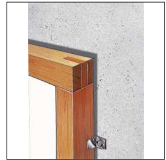
Butyl/Bitumenprimer dik op de prefab betonelementen opzetten, de 4 benodigde butylhoeken plaatsen en de primer laten drogen.
