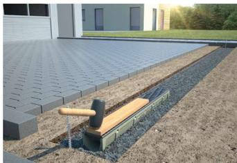
3. Rinnenstrang, Einlaufkästen auf das Betonbett aufsetzen. Bauteile eben ausrichten.
